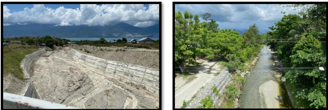
Gambar 6 Tanggul beton massif di Sungai Watutela Kelurahan Tondo Kecamatan Mantikulore (kiri) dan tanggul bronjong di Sungai Lambagu Kelurahan Pantoloan Kecamatan Tawaili (kanan), Kota Palu
